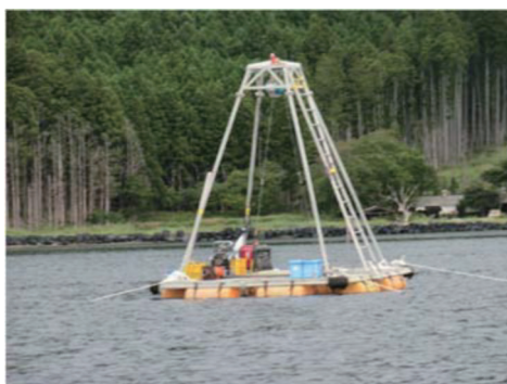
採泥用に海上に設置した櫓
