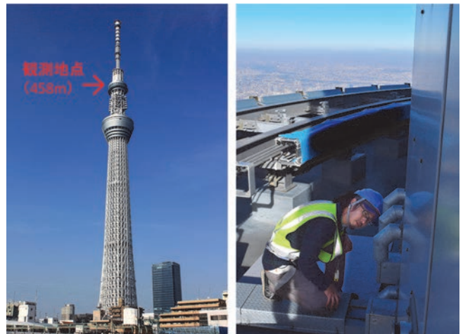
図 東京スカイツリーの地上高458m部に設置した大気観測地点（左：タワー外観と観測地点、右：タワー外壁に設置した空気取り込み口、内部よりポンプでバイオエアロゾルを吸引している）
